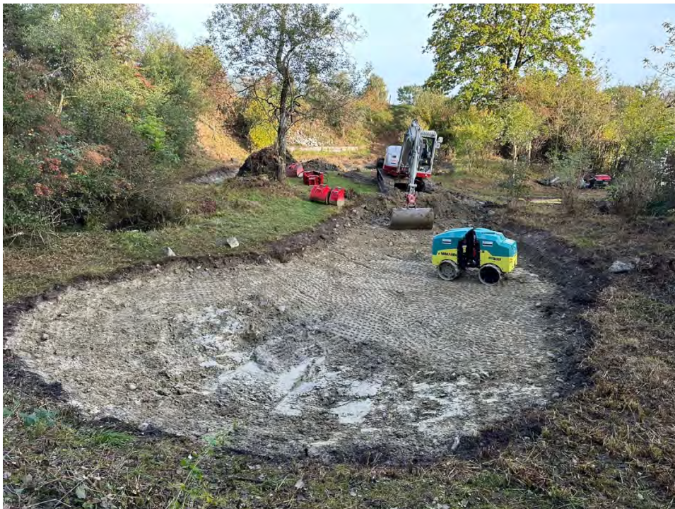
Abb. 1: Beginn der Arbeiten
