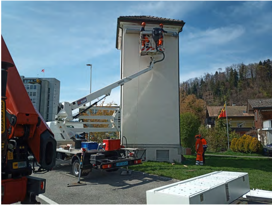
Abb. 3: Die BKW hat freundlicherweise ein Montage-Team zur Verfügung gestellt, welches innerhalb weniger Stunden das Vordach sowie den Windkasten montiert.
