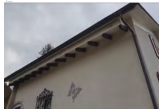
Unter dem Dach wurden Schlitz angebracht für Fledermäuse und Vögel
