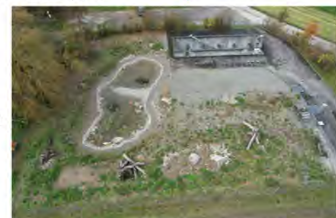
Kläranlage nach Abschluss des Projekts
