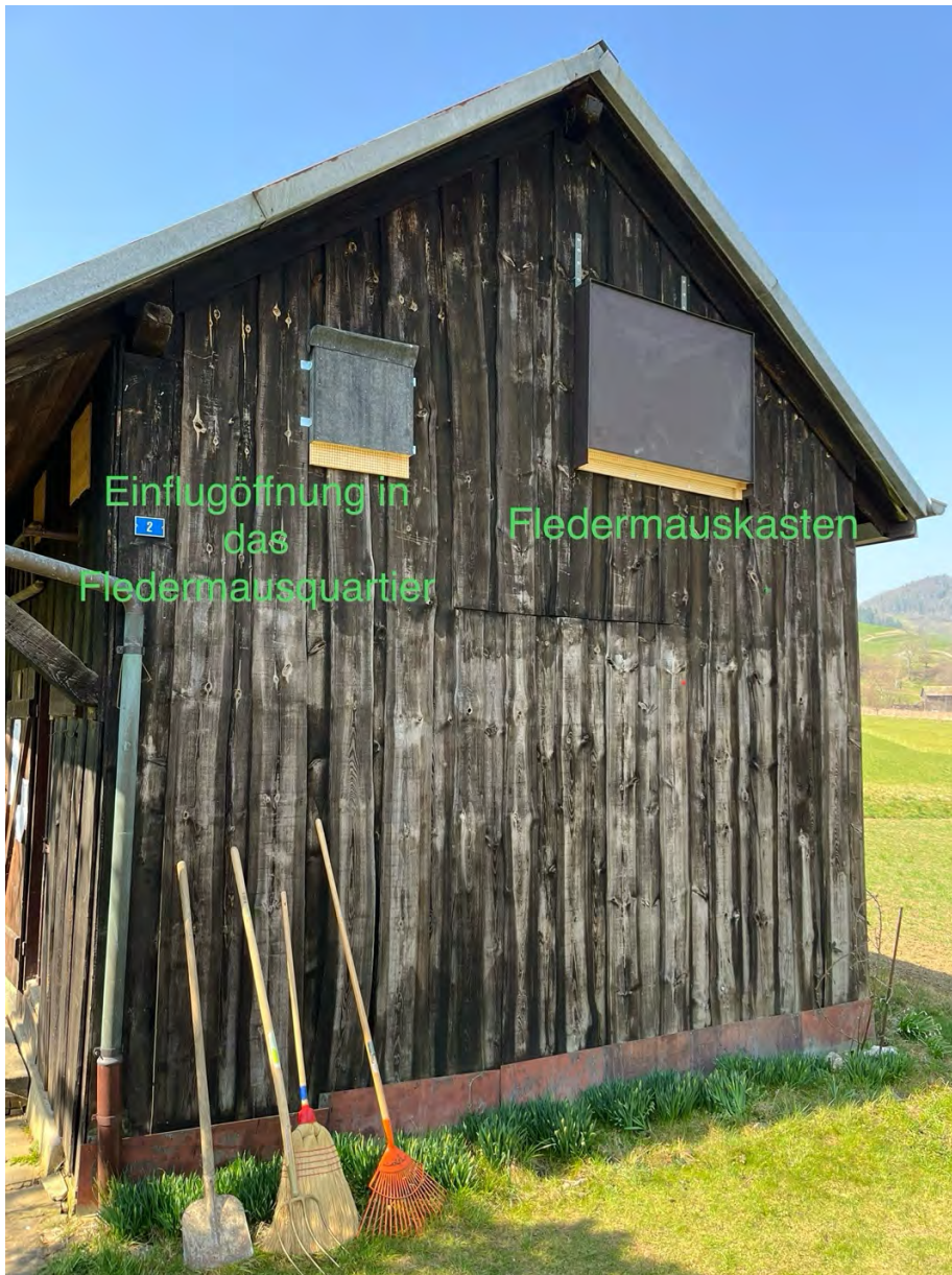
Abb. 1: Freier An- und Abflug beim Chalchhofenschürli. Links: Klettereinstieg in Dachraum, Rechts: grosser Fledermauskasten.
