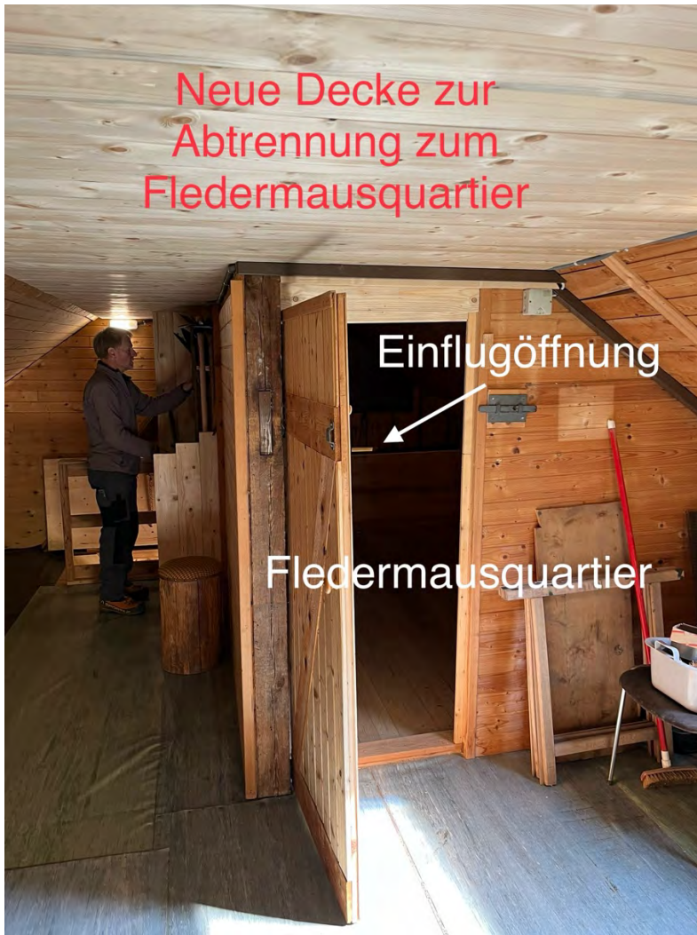
Abb. 3: Abgehängte Decke und Tür zum Fledermausquartier (ungestörte Fledermauszone/Ruhezone)
