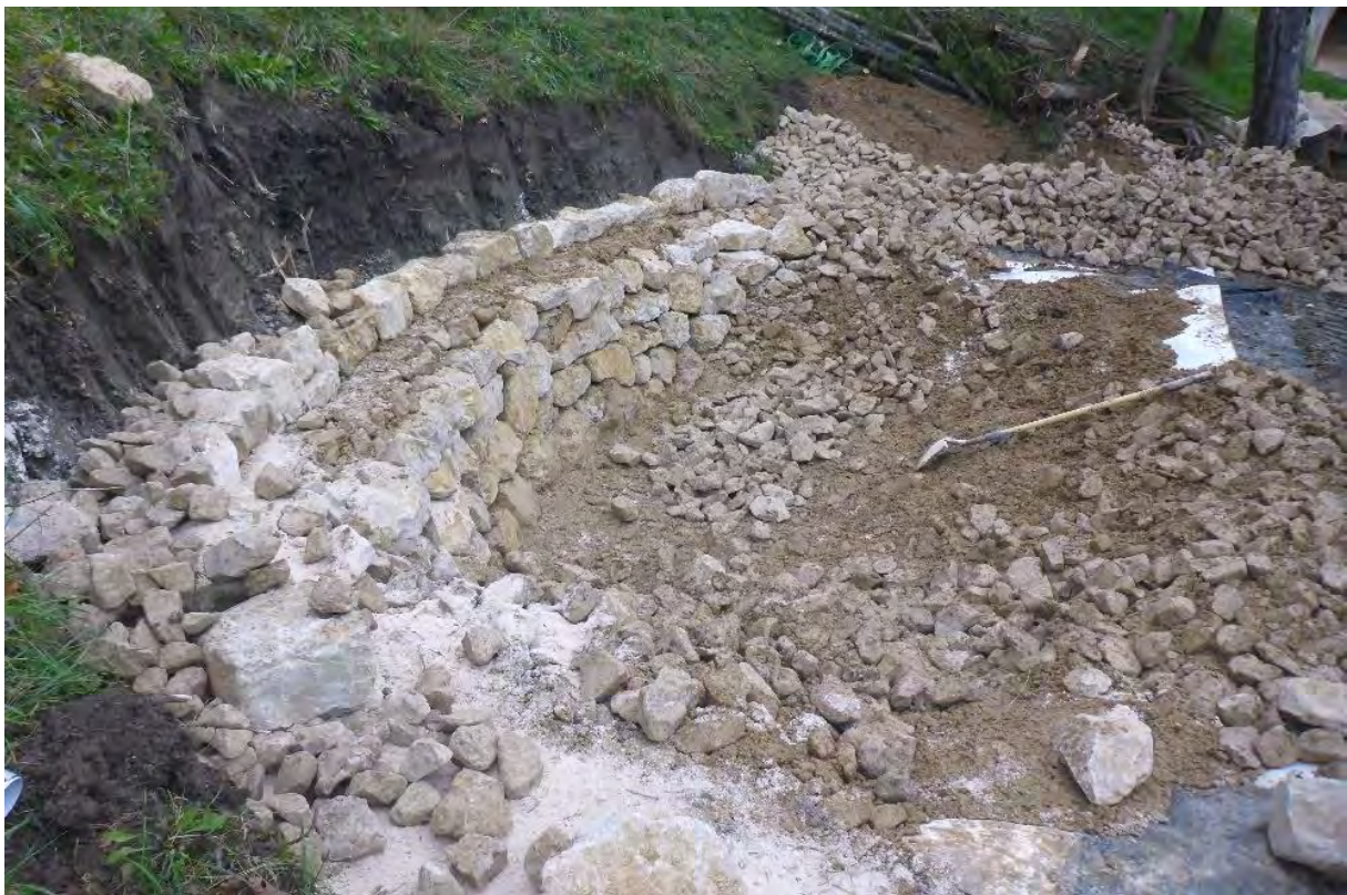
Abb. 10: Die Weihermauer ist fertiggestellt. Oberhalb des Wasserspiegels entsteht etwas abgesetzt als Böschungssicherung die Trockenmauer.
