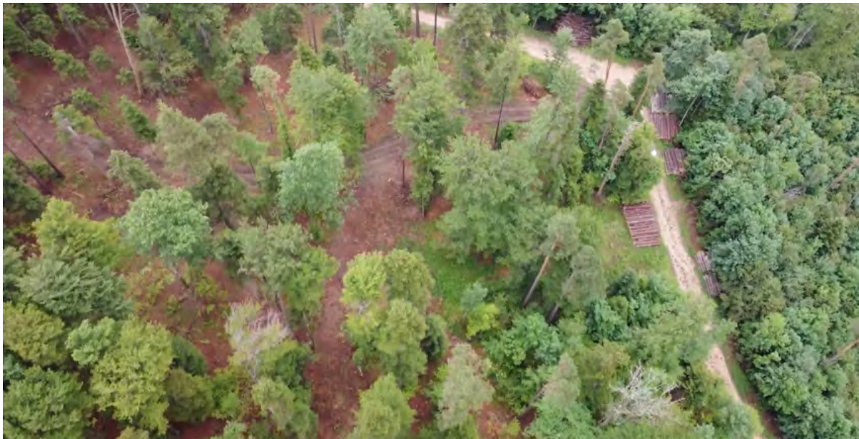
Abb. 6: Luftbild der Fläche W2 nach Abschluss der waldbaulichen Arbeiten.
