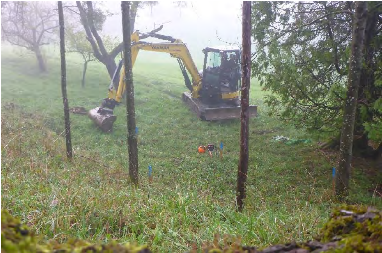
Abb. 5: Baubeginn, die Profile kennzeichnen die Lage des Weihers.
