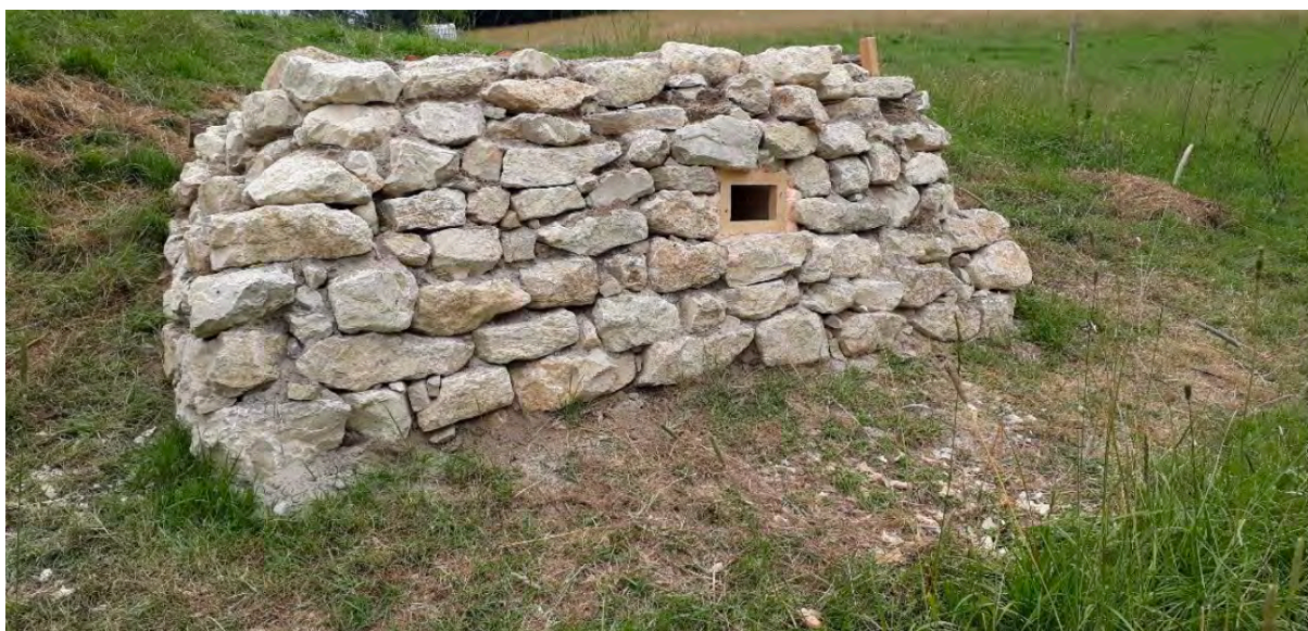
Abb. 4: 01.06.2022: Fertige Trockenmauer von unten, 3.0 m breit und ca. 1.2 m hoch. Rechts, ca 50 cm ab Boden, der Eingang zu einer Nisthilfe (Steindeckel mit Flugloch fehlt noch)
