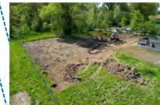
Oberbodenabtrag für eine Magerwiese
