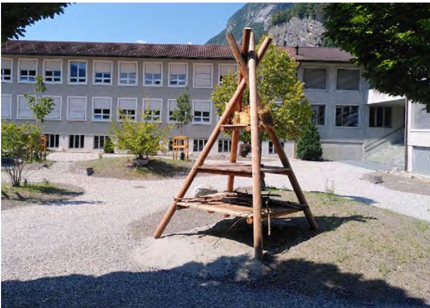
Abb. 14: Der Lebensturm im Rohbau vor der Befüllung durch Schulklassen.
