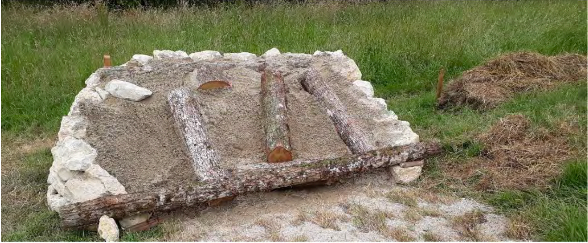
Abb. 5: Trockenmauer von oben: Mit Sand hinterfüllt und mit ein paar Holztrümmeln bestückt
