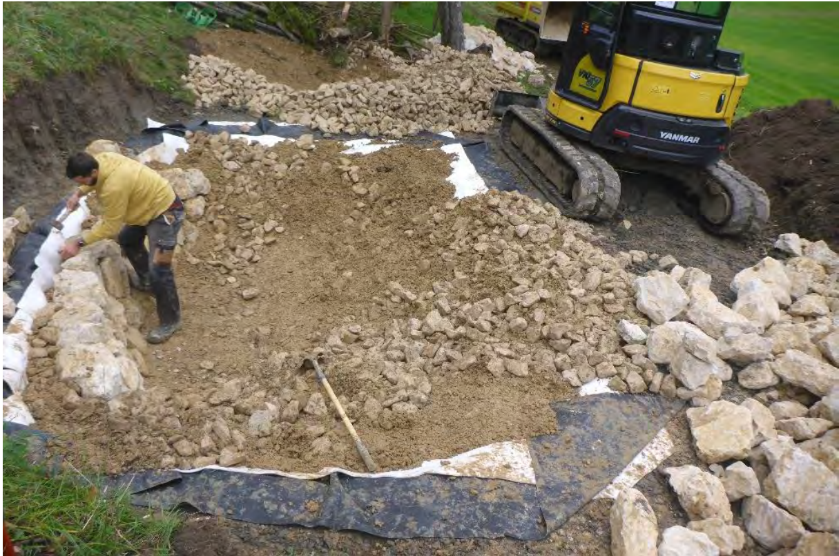
Abb. 9: Ein Teil des Weihersubtrats (Kalkschroppen und Gelbkies) ist bereits eingebaut. Böschungseitig wird die Mauer aus formwilden Kalksteinen gebaut.
