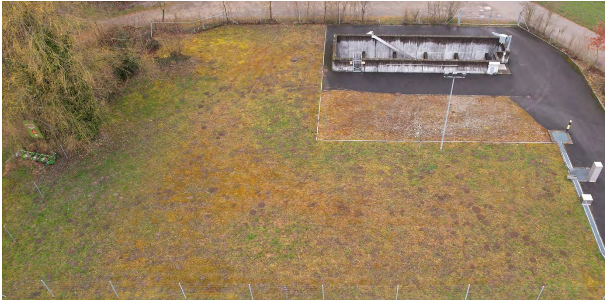
Abb. 20: Luftbild vor der Umsetzung der Massnahmen
