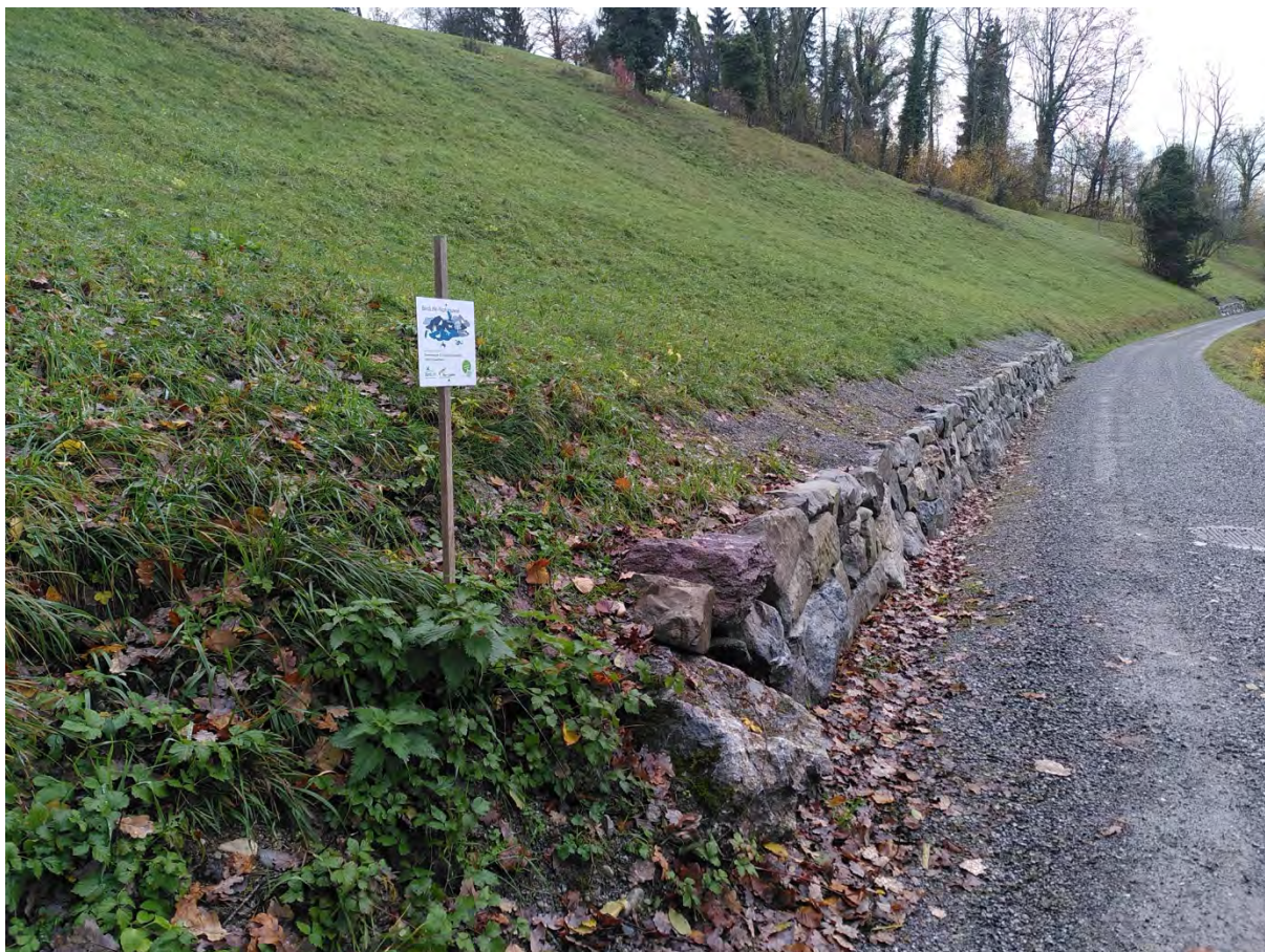
Abb. 1: Die Trockensteinmauer mit der Hinweistafel
