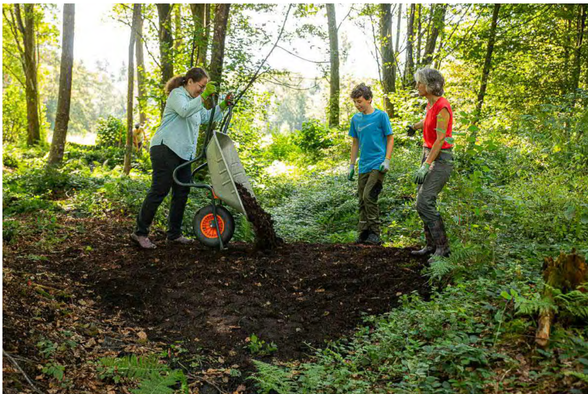
Abb. 10: Arbeitseinsatz am 02.09.2023: Ergänzung und Optimierung der Grabenverfüllung
