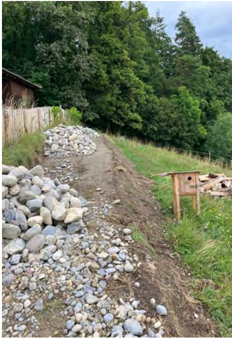
Abb. 3: Der vorbereitete Unterbau
