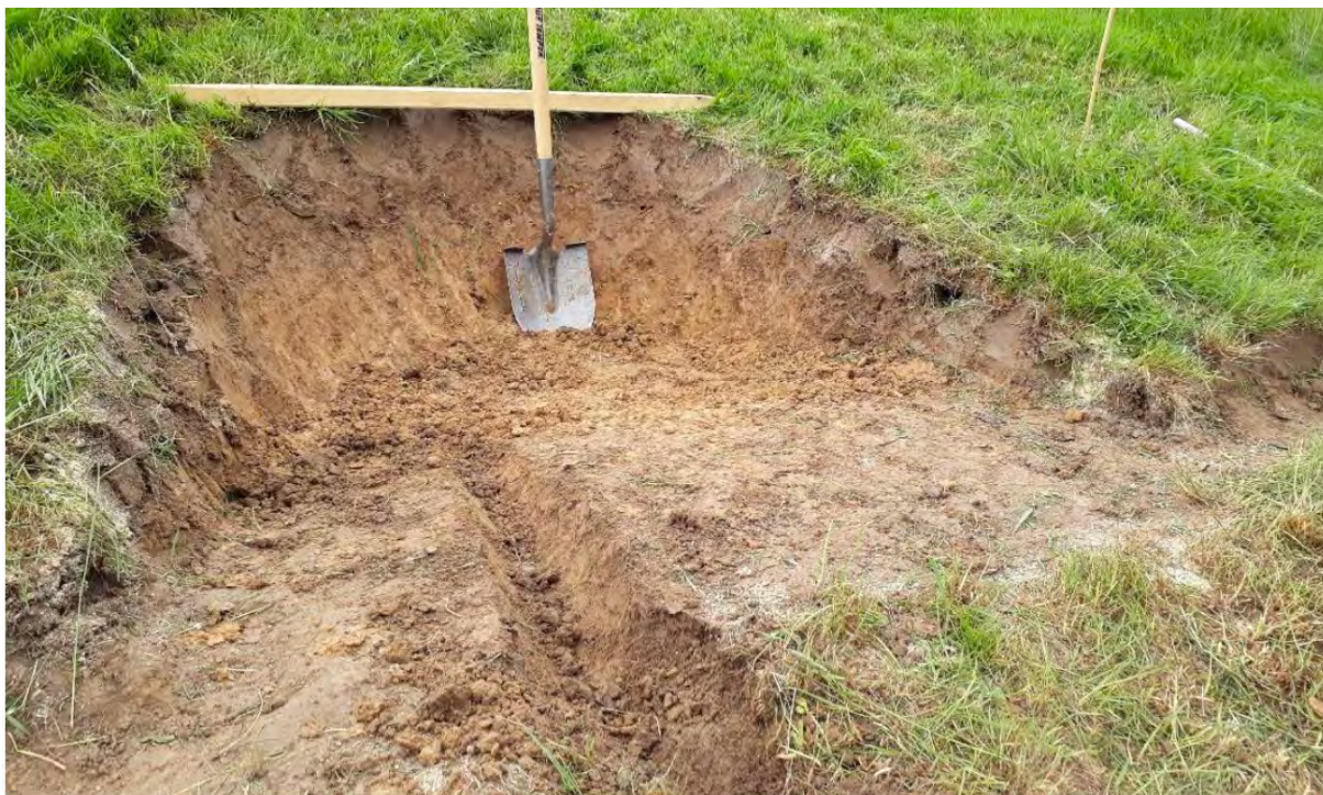
Abb. 3: Aushub mit Drainage; darauf kamen 10 cm Brechsotter, darüber Heu, darüber Sand
