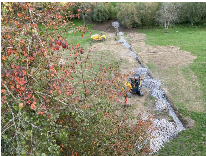
Abb. 2: Ausbau einer alten betonierten Drainageleitung
