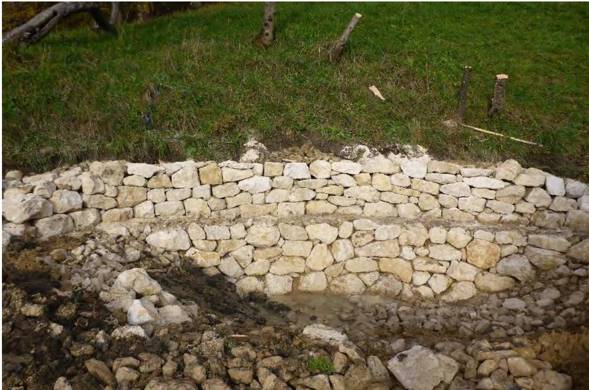
Abb. 12: Die fertiggestellte Mauer. Als Decksteine wurden möglichst grosse und plattige Steine gewählt. Das Weihersubstrat ist eingebaut.
