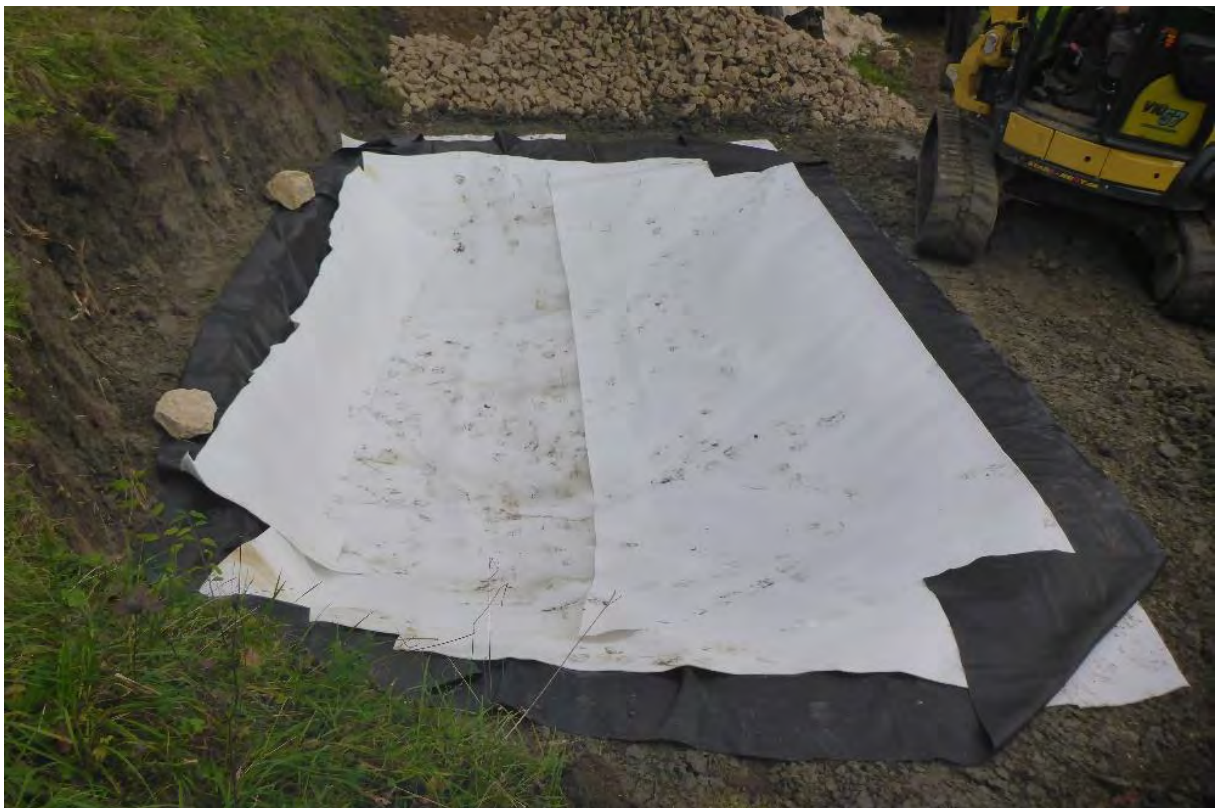
Abb. 8: Das untere Schutzvlies, die Kautschuk-Folie und das Schutzvlies auf der Kautschukabdichtung sind verlegt. Nun kann das Weihersubstrat eingebaut werden.
